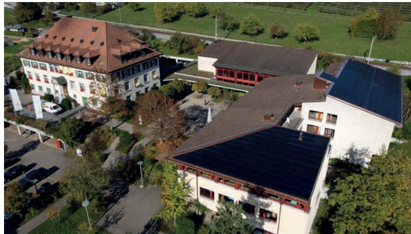
Der Strickhof Wülflingen mit PV-Anlage
